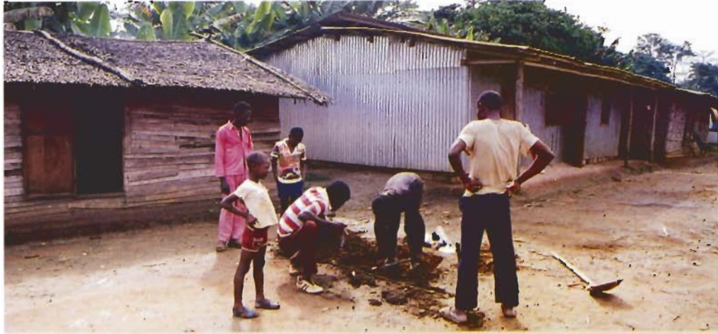
Travaux sur le site de Mbam. Excavation on the Mbam site.
