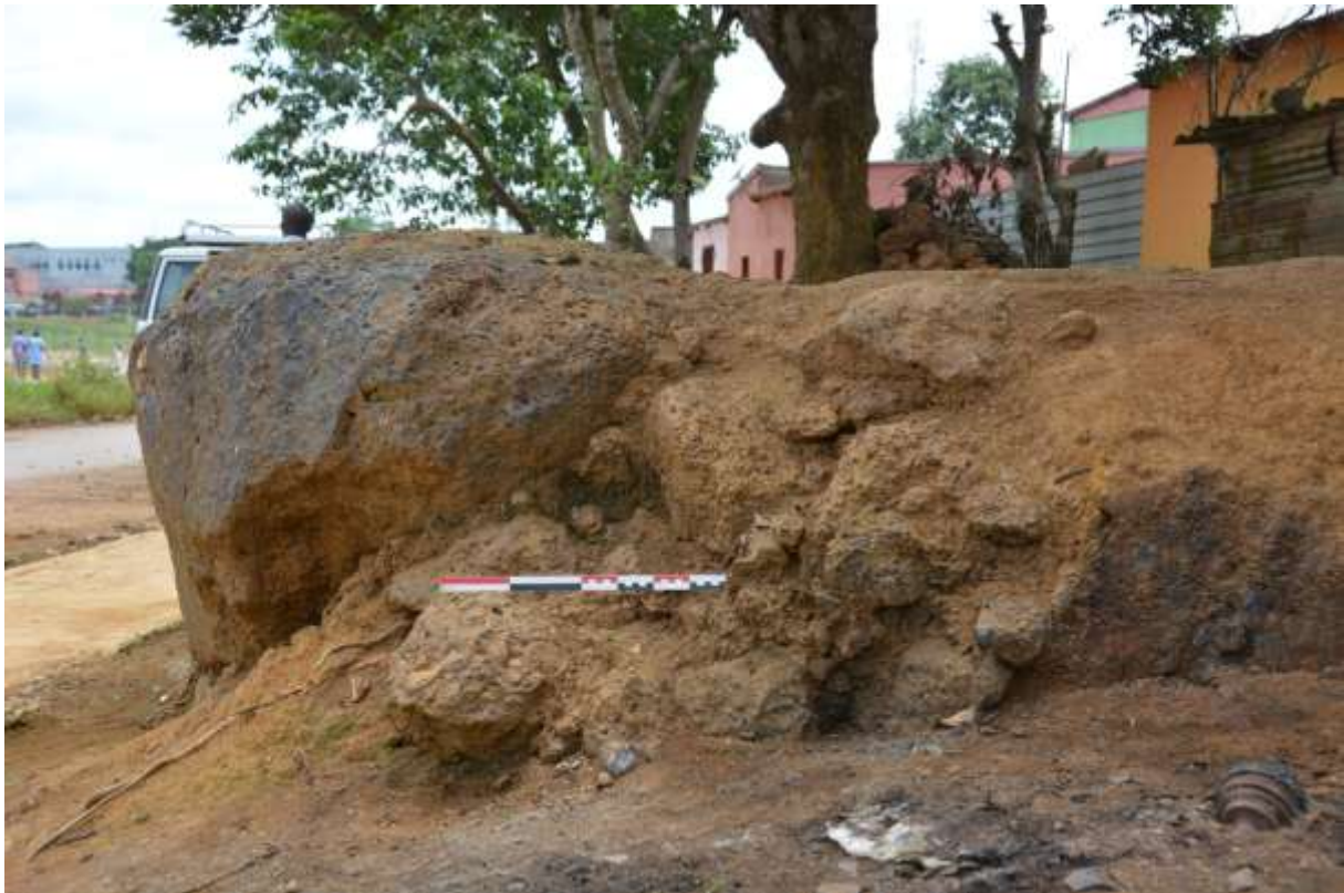
Figure 11: Coupe du mur étudié. Gros blocs de latérite prenant appui sur des dalles de latérite laissées en place. (© Maria Lopes)
