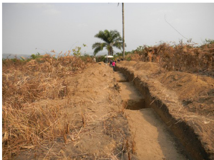
Figure 11.10 : Zone du cimetière, Tranchée sud, vue vers le sud
