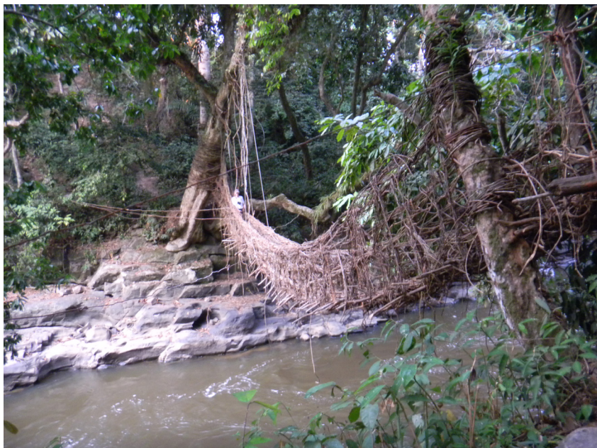
Figure 10.98 : Malau. Haut : vue générale sur le paysage du canyon de l'Inkisi sous le village de Malau ; Bas : le pont de liane sur l'Inkisi
